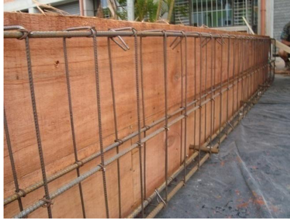
Figura 1. Detalle de construcción de las BM60.
